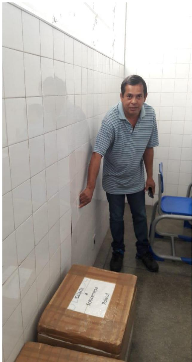
No refeitório e Banheiros nos deparamos com diversas placas de azulejos se desprendendo das paredes, colocando em risco iminente a vida dos servidores municipais, sugerimos a interdição destes ambientes até a devida manutenção
